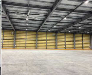
一般倉庫内部
