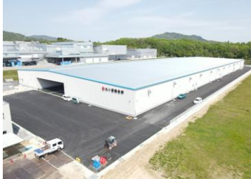
一般倉庫（進入路より）
