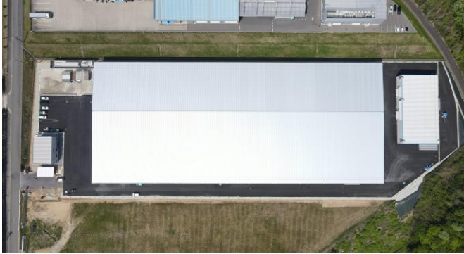
空撮による敷地全景
