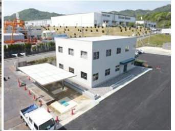
事務所棟外観
